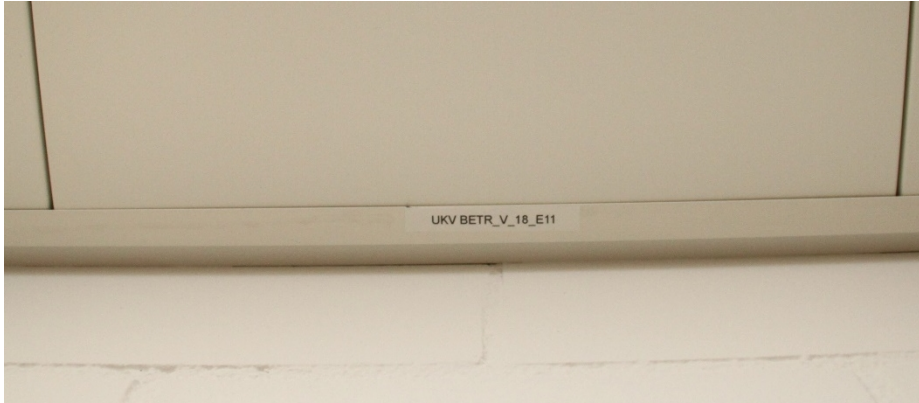
Abbildung 14: Beispiel Beschriftung Standort UKV Dose in Hohldecke
