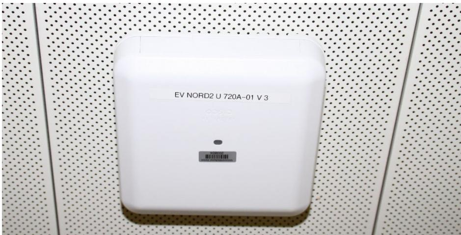
Abbildung 10: Beispiel WLAN Beschriftung – WLAN ACESSPOINT dürfen nicht über Patientenbetten installiert werden
